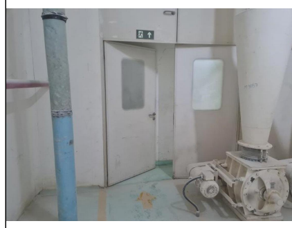
6.8 - FOTO DA SAÍDA DE EMERGÊNCIA
