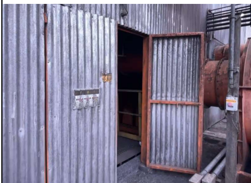
6.11 - FOTO DA SAÍDA DE EMERGÊNCIA
