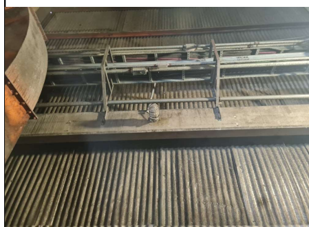
6.8 - FOTO DA LUMINÁRIA DE EMERGÊNCIA
