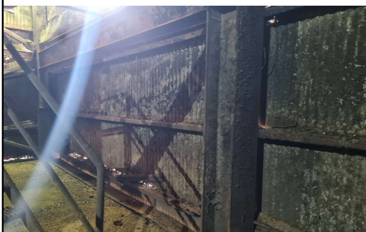
6.3 - FOTO DO AMBIENTE DE INSTALAÇÃO (LATERAL LADO - MAR)
