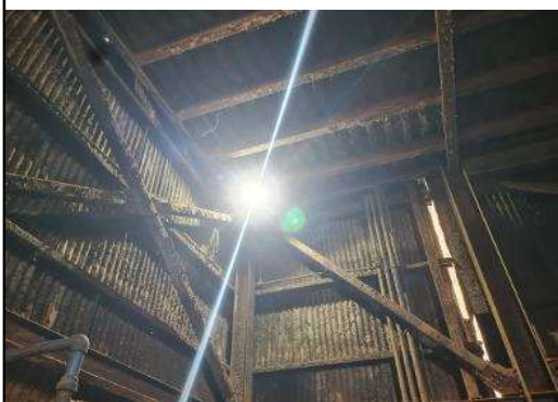
6.7 - FOTO DA ILUMINAÇÃO
