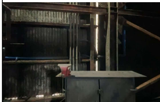
6.4 - FOTO DO AMBIENTE DE INSTALAÇÃO (LATERAL LADO - CENTRO)
