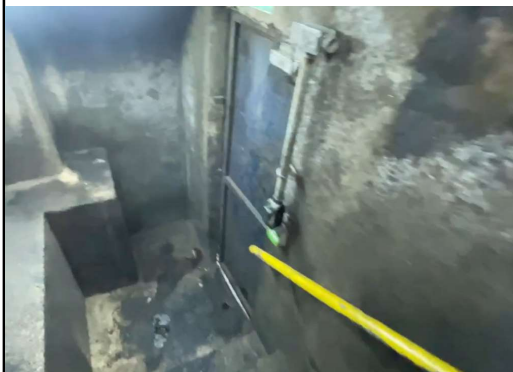
6.11 - FOTO DA SAÍDA DE EMERGÊNCIA
