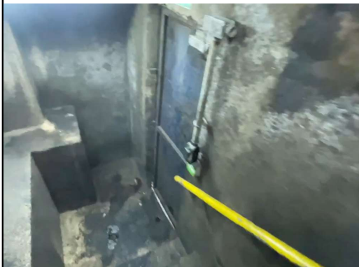
6.11 - FOTO DA SAÍDA DE EMERGÊNCIA
