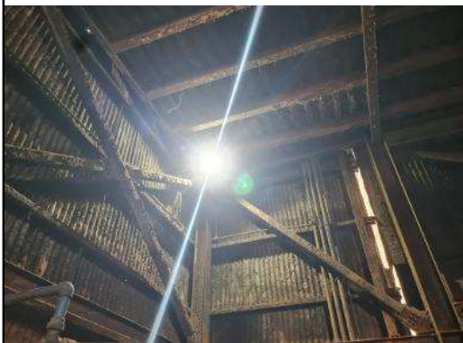
6.7 - FOTO DA ILUMINAÇÃO
