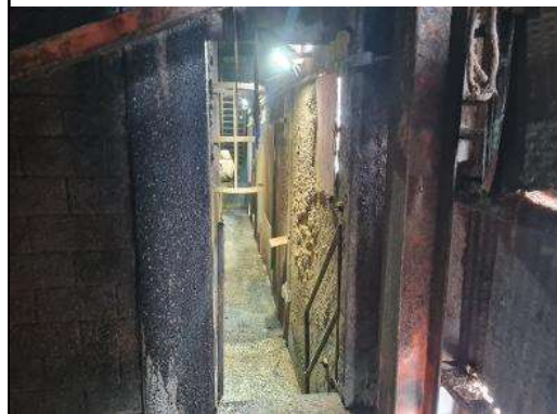
6.12 - FOTO DA PLAQUETA DA SAÍDA DE EMERGÊNCIA
