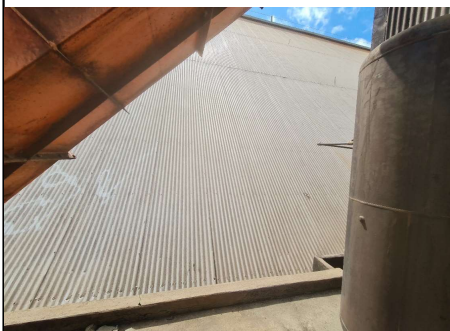
6.3 - FOTO DO AMBIENTE DE INSTALAÇÃO (LATERAL LADO - MAR)
