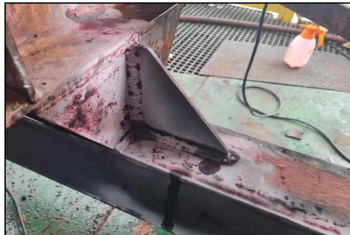
ACIONAMENTO EXTERNO REFORÇO VIGA 04 - REVELADOR
