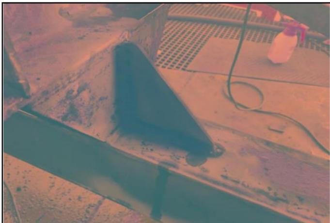
ACIONAMENTO EXTERNO REFORÇO VIGA 04 - LP
