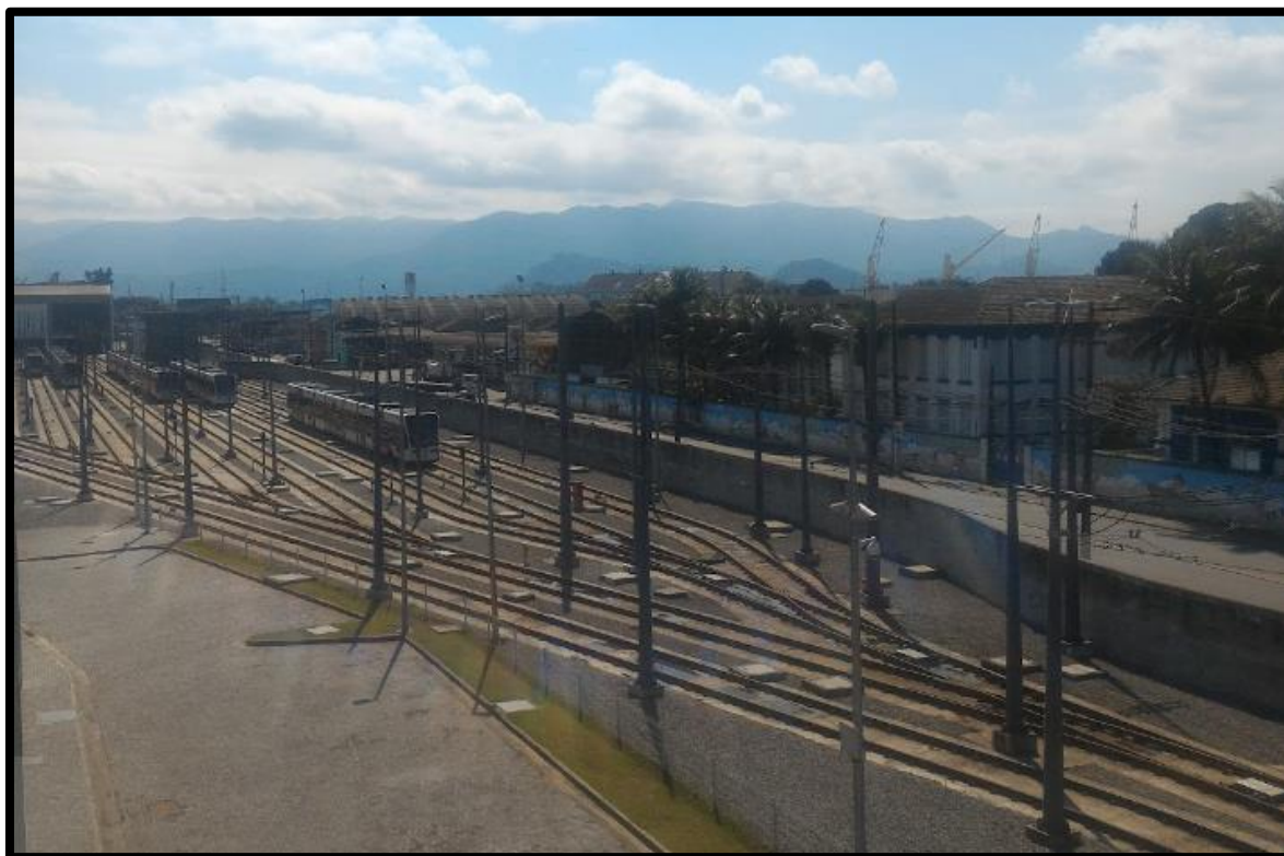
Figura 15: Vista de parte do Pátio de Manobras de Veículos - VLT Baixada, na área de influência (área leste de do empreendimento).
