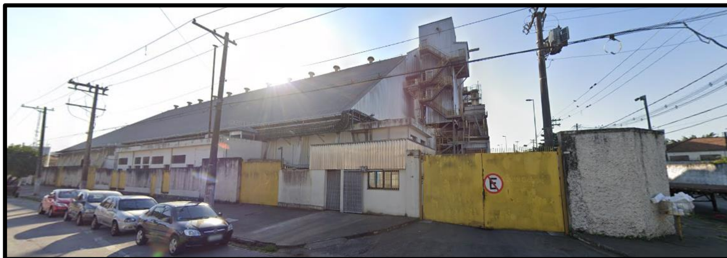
Figura 5: Vista frontal do empreendimento.
