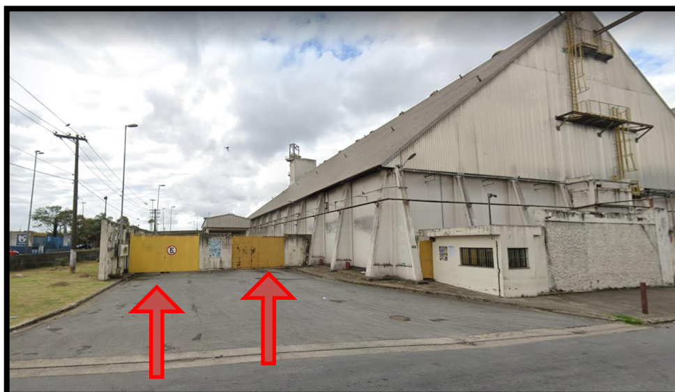
Figura 10: Vista do acesso de caminhões
