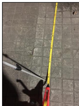
Distância da parede aprox. 1,8 metros
