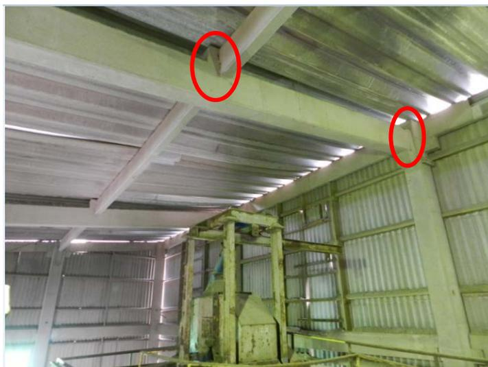
Os pilares e vigas que se encontram com corrosão atmosférica deverão ser tratados com jateamento e pintura, em alguns casos será necessária substituição do trecho.
